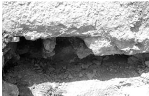
Sl. 4 - ĆDžS, ostaci drvenog roštilja, uvećano (Projekat rehabilitacije „Ćuprijska džamija u Stocu“)
