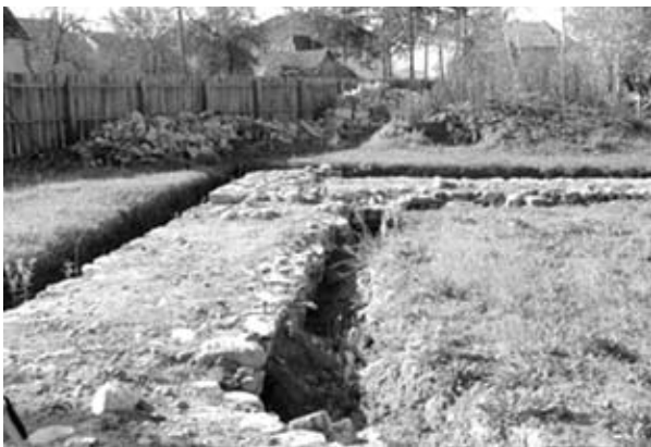
Sl. 5 - ADŽBP, trakasti temelji na jugoistočnoj strani (Projekat rehabilitacije „Azizija džamija u Brezovom Polju“)
