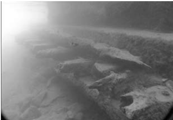
Sl. 7 - SMK, podvodni snimak stanja drvenog roštilja (Projekat istražnih radova i izvođenje istražnih radova „Stari most u Konjicu“)
