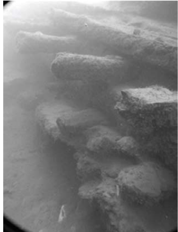
Sl. 8 - SMK, podvodni snimak stanja drvenog roštilja, uvećano (Projekat istražnih radova i izvođenje istražnih radova „Stari most u Konjicu“)
