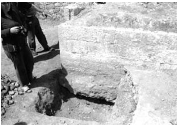
Sl. 1 - PDŽS, ostaci drvenog roštilja ispod temelja munare (Projekat rehabilitacije „Podgradska džamija u Stocu“)
