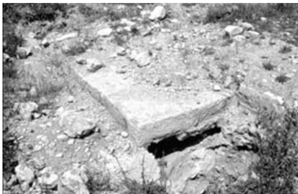
Sl. 3 - ĆDžS, ostaci drvenog roštilja ispod temelja munare (Projekat rehabilitacije „Ćuprijska džamija u Stocu“)
